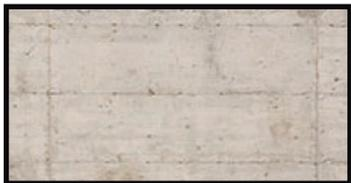
En la intervencion contemporanea del proyecto se utiliza el muro de concreto reforzado a la vista, este al ser estructural se muestra como es de manera franca. Los muros fueron fundidos por partes con un encofrado rectangular que es lo que permite que se vea el patron en la fachada. Se precuro que se vieran los cambios de color del concreto en las diferentes fundiciones lo que le da caracter al edificio.
