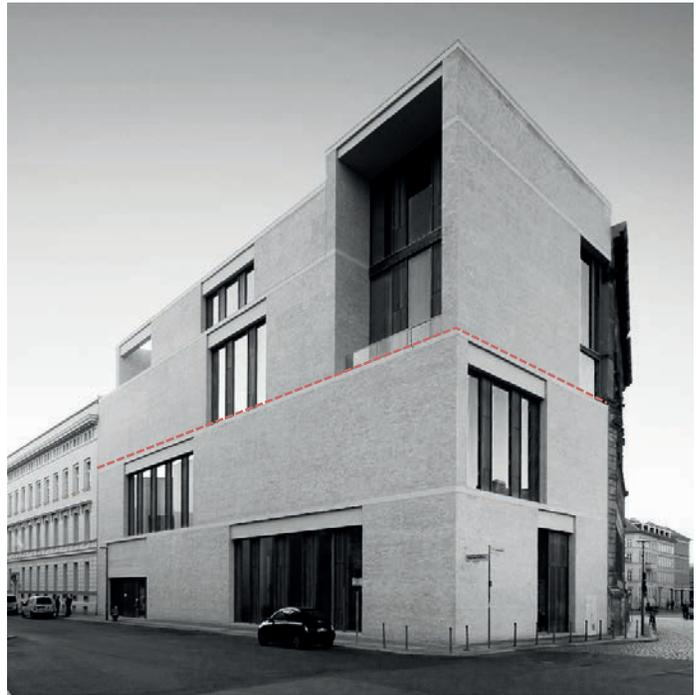
El arquitecto hace evidente unos elementos continuos que rematan la hoja de ladrillo en cada piso. Estos elementos actúan como viguetas que distribuyen las cargas al rededor de los huecos, con ayuda del dintel, y además, es el elemento que une la cara exterior de la fachada, con el interior de hormigón.
