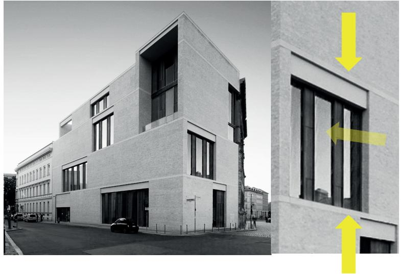
El hueco de las ventanas en este edificio está entendido como un retranqueo en la fachada. Este retranqueo da la sensación de operación de sustracción de la masa del muro de fachada, descubriendo el dintel y dándole paso al acristalamiento en el plano posterior.
