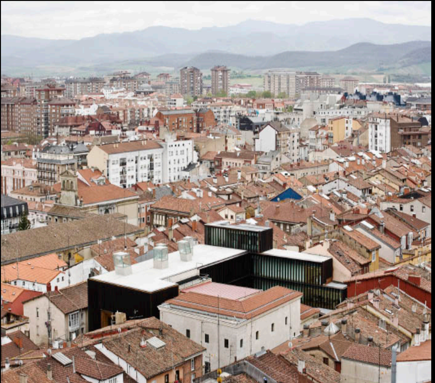
VISTA DE CUBIERTAS
