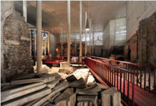
El espacio arqueológico tiene tres elementos los cuales permiten que el edificio pueda establecerse sobre él. Las columnas insertadas dentro del cerramiento, el perímetro de columnas de diámetro pequeño que se insertan como pequeñas agujas y una pasarela en madera que permite que las personas lo atraviesen.
