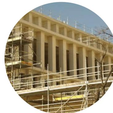
Granito extremeño: es una roca compuesta por cuarzo, feldespato y mica, es un material que se solidifica lentamente y a gran presión. En el museo es usado para los acabados en fachada.
