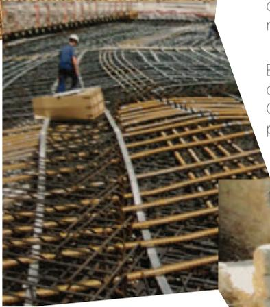
Esta losa postensada cubre una superficie de unos 500 metros cuadrados aproximadamente. los cables de acero que se ven en la imagen se contraen reduciendo el espesor de la losa de 1.40 metros a 0.80 metros.
