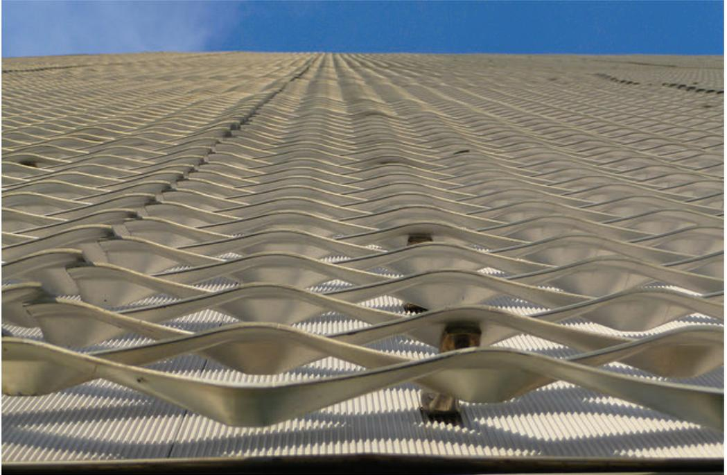
La técnica en fachada se soluciona con planchas de aluminio estiradas y ancladas. En fachada no se reconoce la estructura, el edificio se convierte en una escultura homogénea con algunas aperturas de luz.
