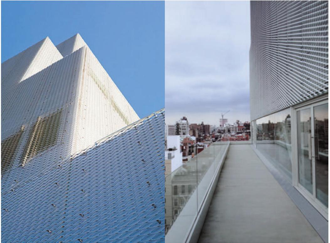
La ligereza es una operación empleada en toda la arquitectura de SANAA. Se manejan materiales constructivos como el acero, que permitan elementos extremadamente esbeltos. La fachada se compone por una piel de a base de planchas de aluminio estirado y se sostiene mediante anclajes de acero inoxidable. Las planchas se fijan sobre una chapa de aluminio y se distancian para dar la sensación de flotar en el aire. 6.
