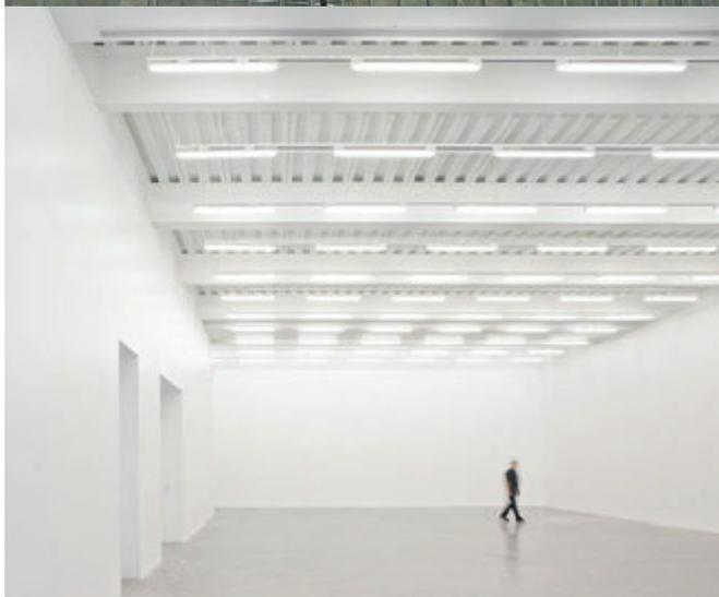
El proceso constructivo de acero tiene juntas a base de platinas del mismo material. Las vigas finalmente se dejan a la vista en los pisos de galería y se pintan de blanco para dar un conjunto al interior del museo.
